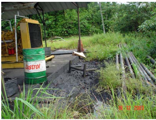
Descargas del generador a producido una superficie contaminada
